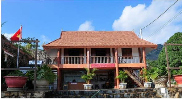
Công trình hiện có
