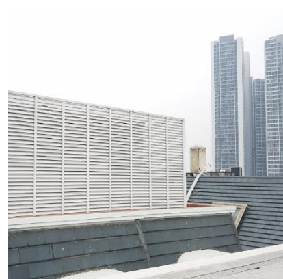
Ảnh tham khảo 7: Biện pháp che chắn đảm bảo mỹ quan thiết bị kỹ thuật công trình.
