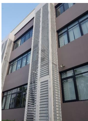
Ảnh tham khảo 7: Biện pháp che chắn đảm bảo mỹ quan thiết bị kỹ thuật công trình.
