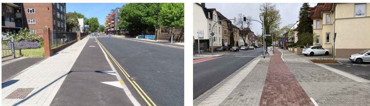
Ảnh tham khảo 18: Kết cấu vỉa hè kết hợp với bó vỉa dạng hạ thấp.
